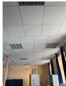
Decke mit alter Beleuchtung
