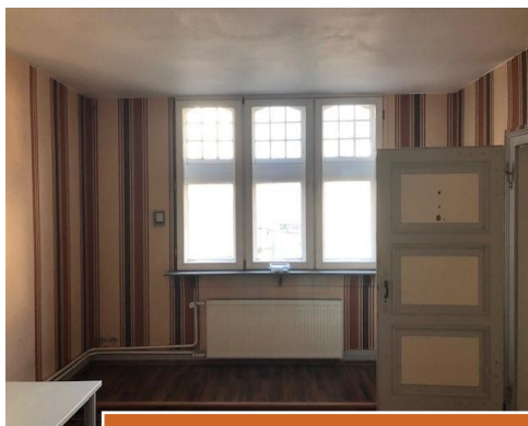
Raum im Hausmeisterhaus vor dem Umbau
