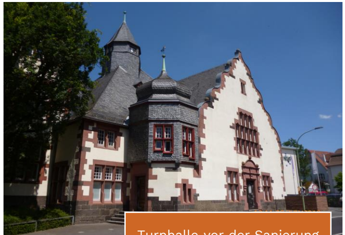
Turnhalle vor der Sanierung
