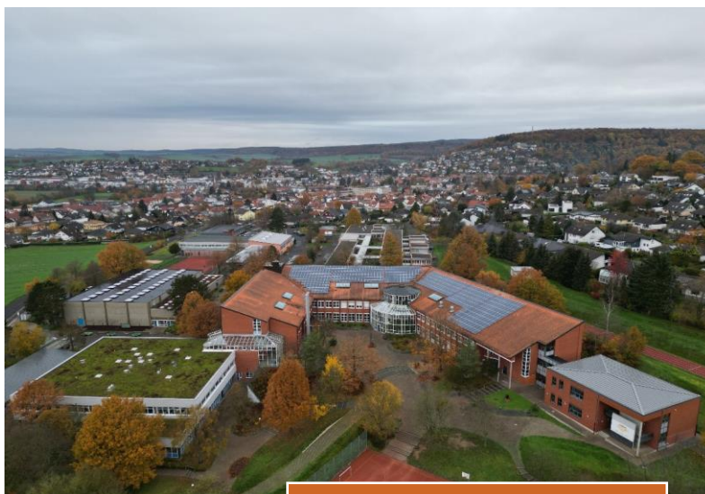
Blick auf das zu renovierende Gebäude
