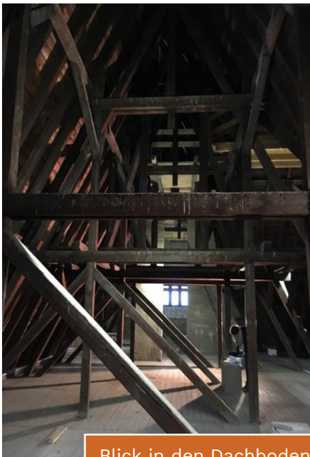
Blick in den Dachboden des Hauptgebäudes
