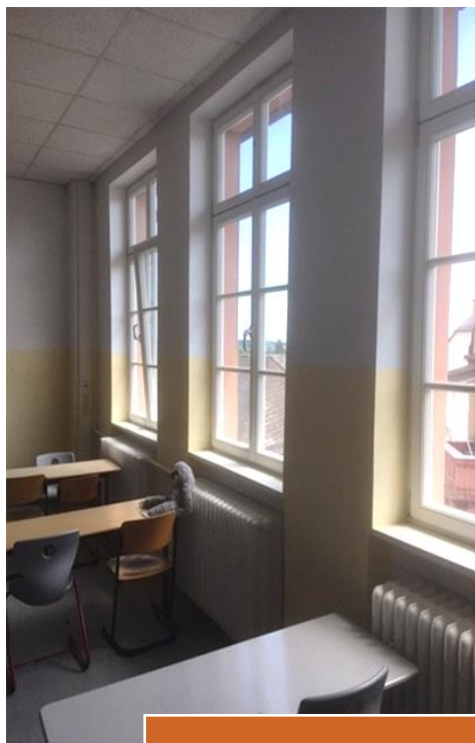
Raum mit neuen Fenstern
