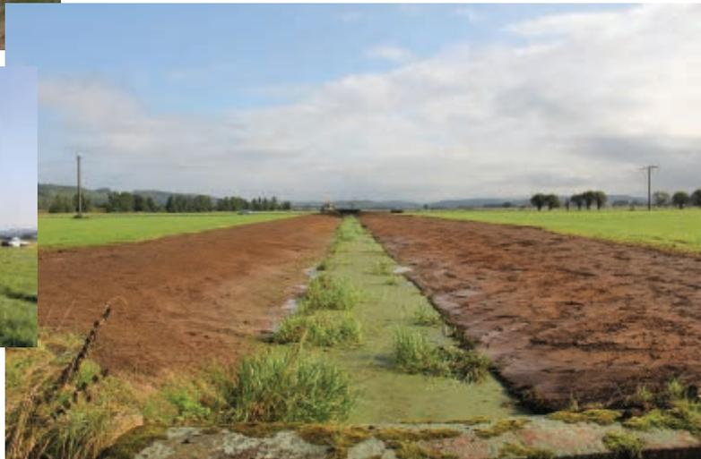
Fotos: Links oben Grabenprofil vor der Bearbeitung, rechts unten nach der Aufweitung
