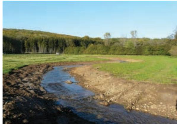
Fotos: Links oben rückgebauter Sohlabsturz, rechts neu angelegte Bachschlinge vor der Flutung; unten neues Bachbett nach Anschluss an den Hauptstrom
