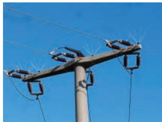
Foto 4: Sicherung mit Büschelabweisern
