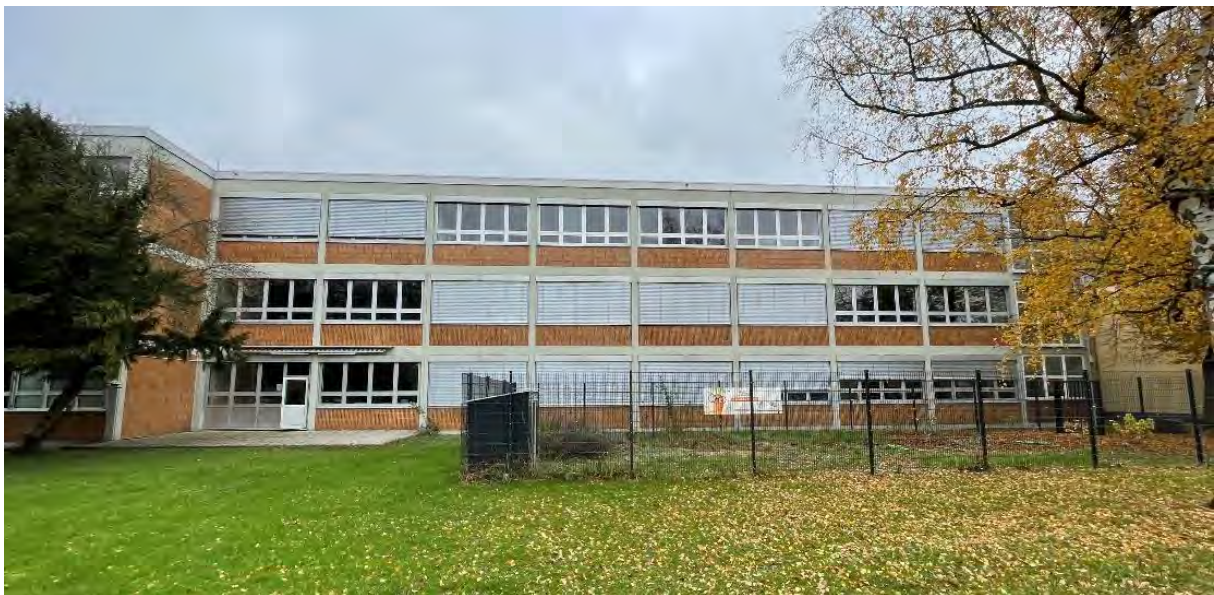
Abbildung 21: Außenraffstores am Gymnasium Nidda
